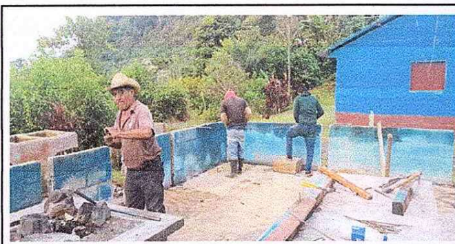
Se observa el cambio del techo de la bodega
