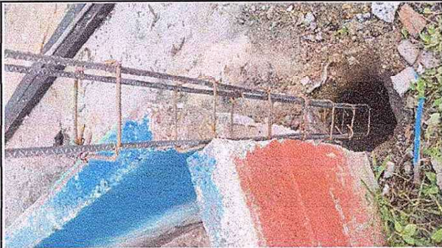
Se observa la colocacion de las columnas de la cocina.
