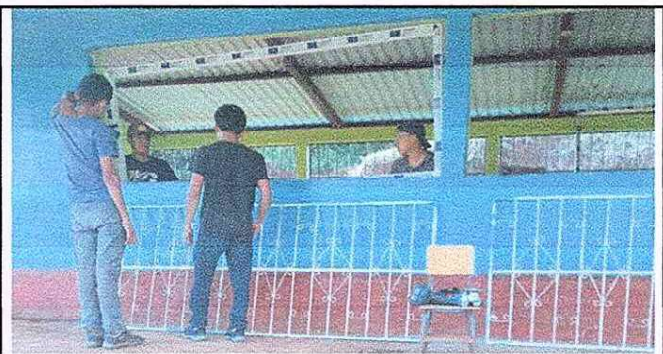
Se observa la instalacion de las ventanas pvc corrediza de la escuela.
