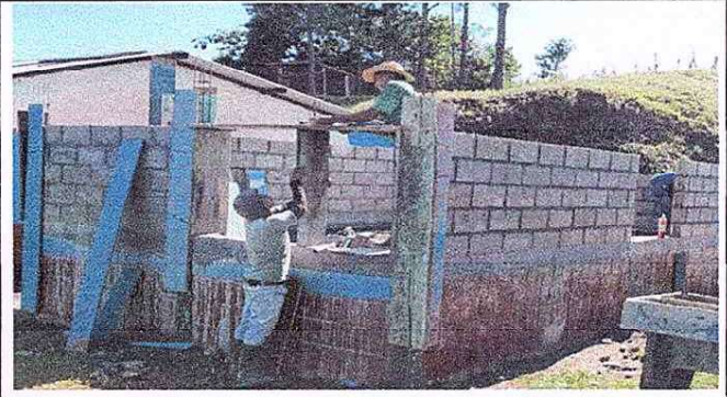
Se observa la colocacion de las paredes de la cocina.
